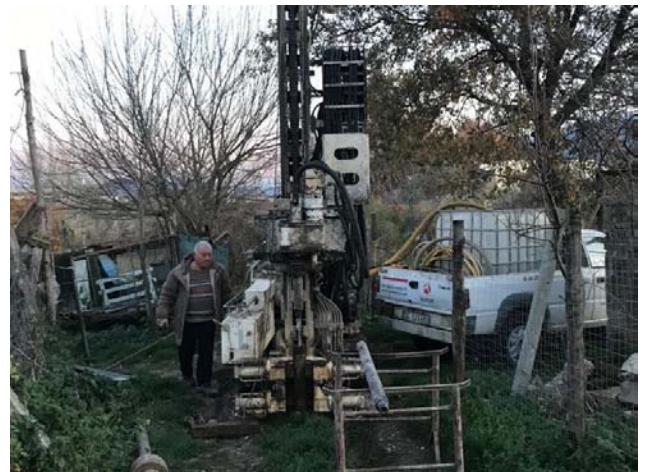
Sondaggio breve S10B (Loc. Masseria Verrusio)
