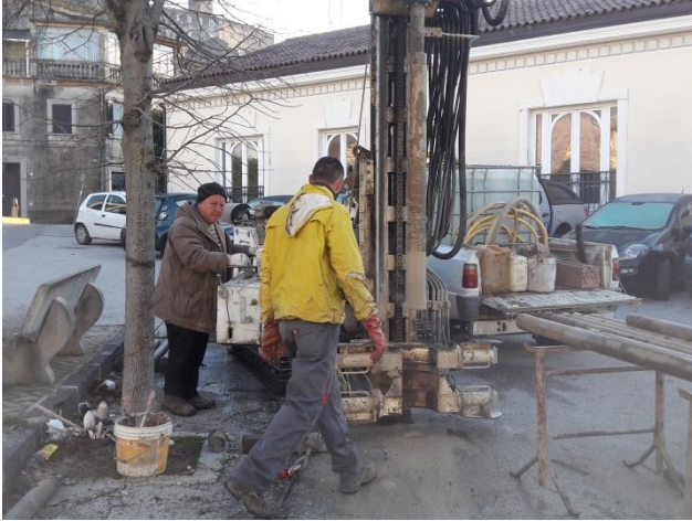
Postazione sondaggio S14
