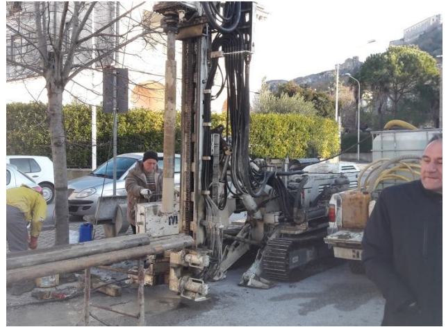
Postazione sondaggio S14
